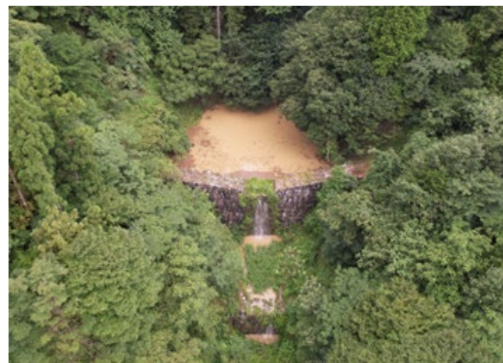
井口谷第2砂防堰堤
