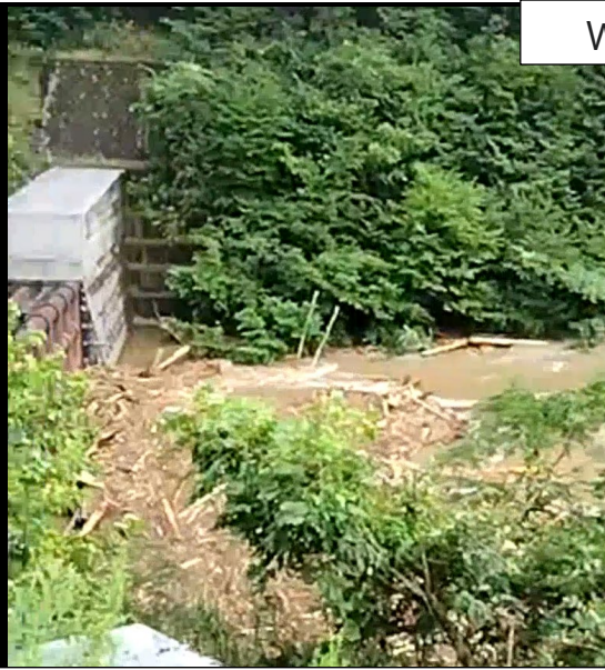
土砂・流木を補足 瀬戸谷第1砂防堰堤
