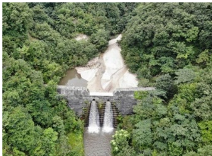
新穂谷第3砂防堰堤
