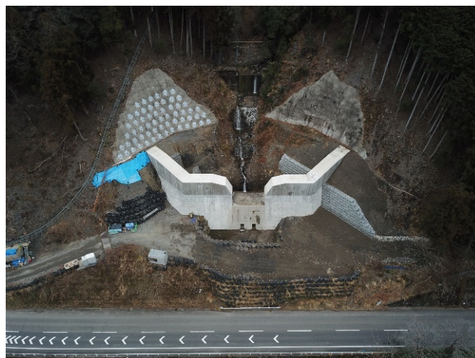
施工状況 令和5年3月現在
