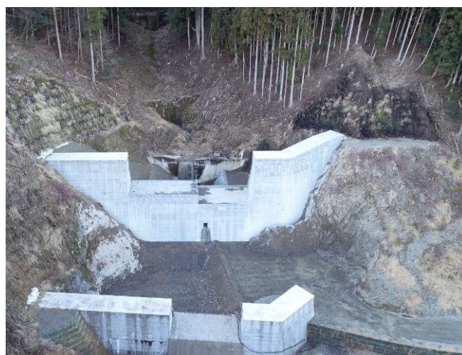
施工状況 令和5年1月現在
