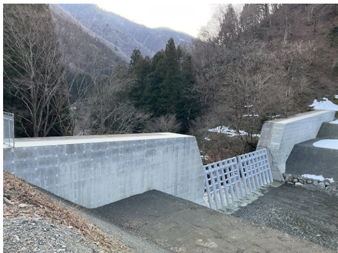
大谷川第3砂防堰堤 令和5年3月 流木止め設置
