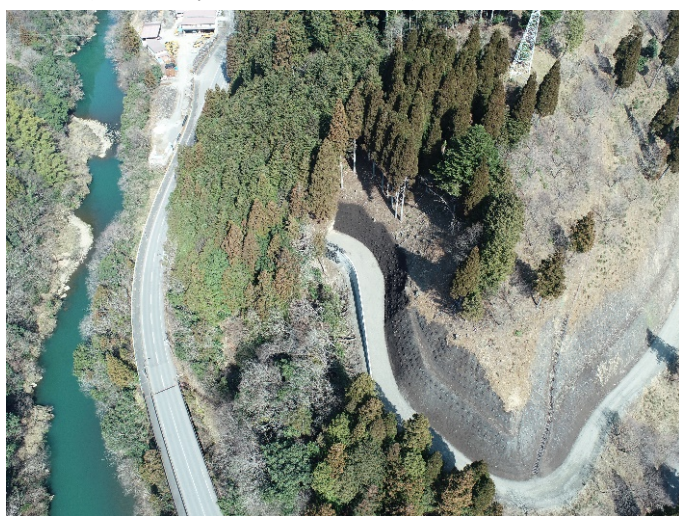
施工状況 令和5年3月現在
