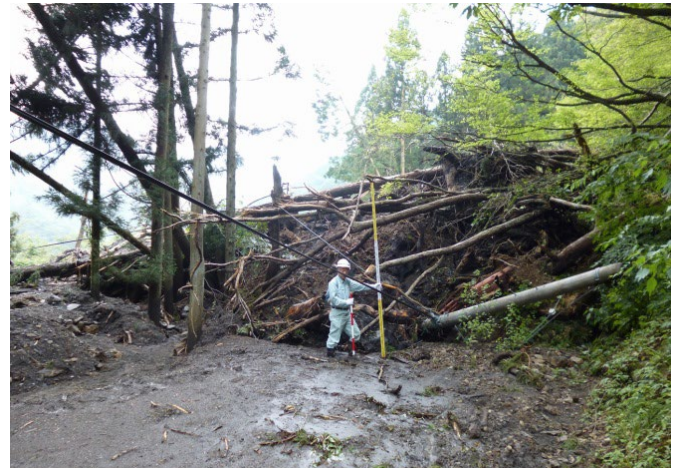
平成26年8月 土石流 国道157号寸断 (2014年) (本巣市根尾大河原)
