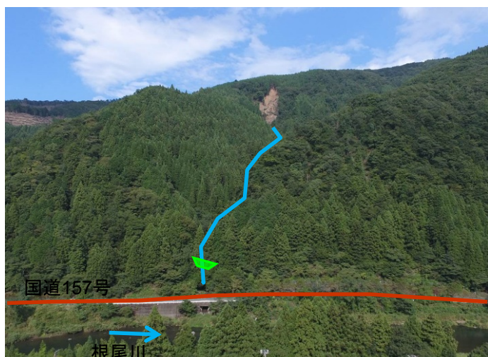
根尾川右岸より蛇抜谷を望む
