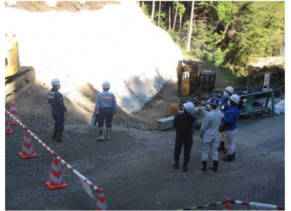
工事現場パトロールの状況（令和4年10月）
