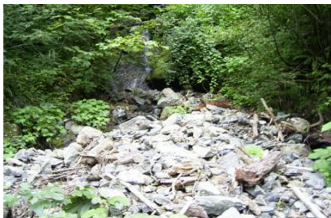
上流部の荒廃状況
