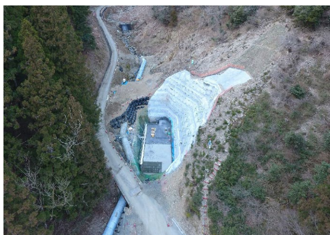
施工状況 令和5年2月末現在
