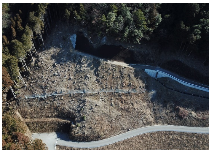
施工状況 令和5年3月現在
