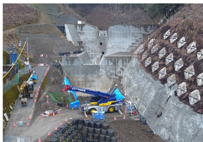
施工状況 令和5年2月末現在
