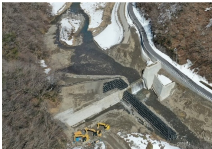
施工状況 令和5年2月末現在
