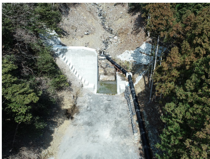
施工状況 令和5年3月現在
