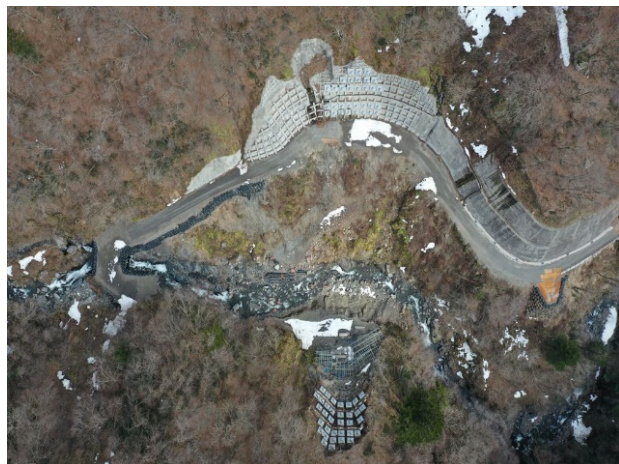
施工状況 令和5年3月現在
