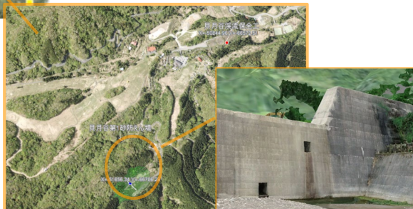
施設・溪流状況確認
