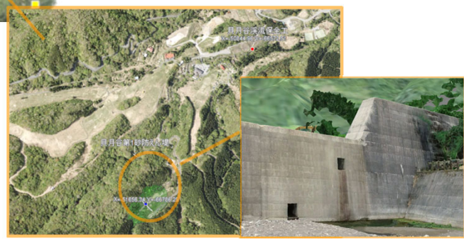
施設・溪流状況確認
