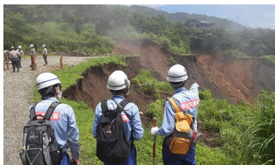
逢初川で発生した土石流災害に対する調査 (熱海市伊豆山2021年7月)
