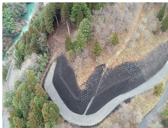
施工状況 2022年3月現在
