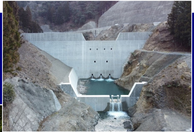
高地谷第1砂防堰堤(2021年度完成)
