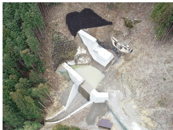
施工状況 2022年3月現在
