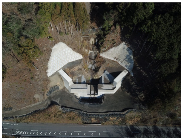
施工状況 2022年2月現在
