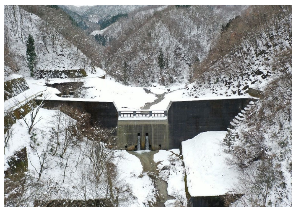
殿又谷第2砂防堰堤 2022年2月 流木止め設置
