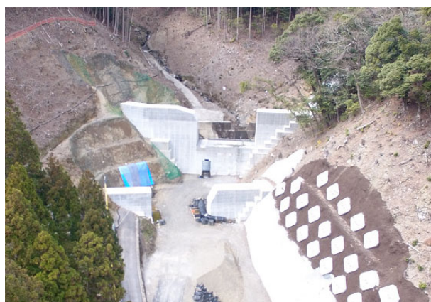
施工状況 2022年3月現在
