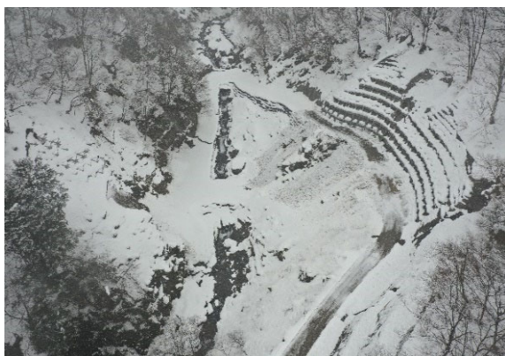
施工状況 2022年1月現在
