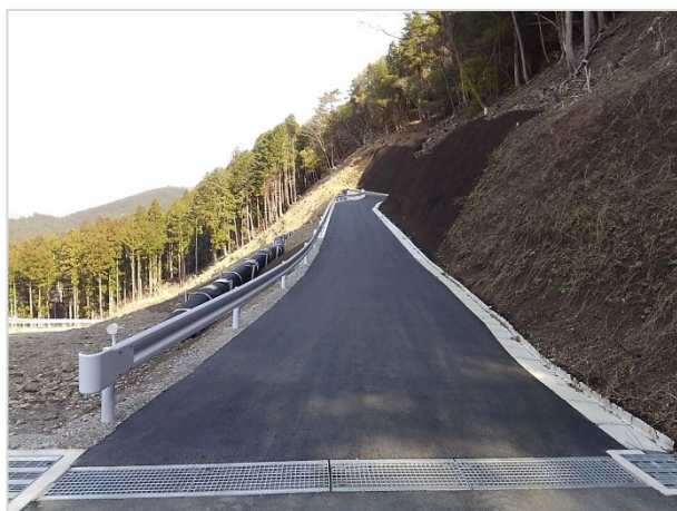
施工状況 2022年3月現在
