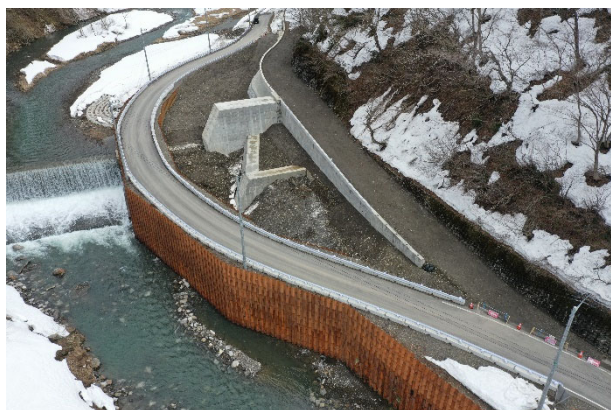
施工状況 2022年3月現在
