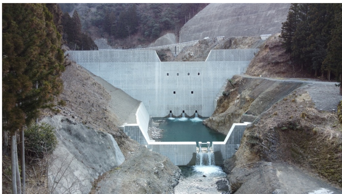
高地谷第1砂防堰堤
