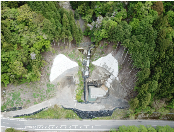
施工当初（2021年4月）
