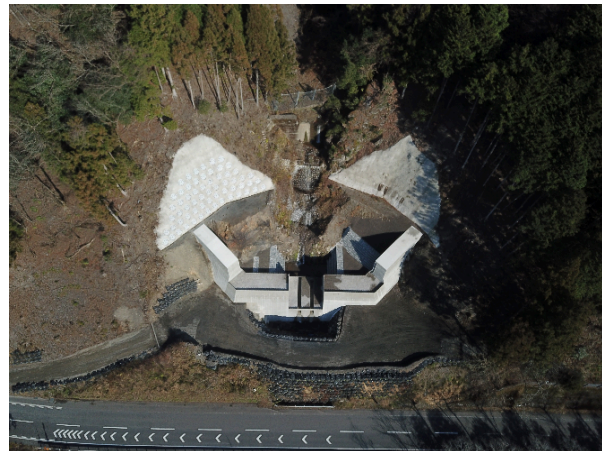
施工完了（2022年2月）
