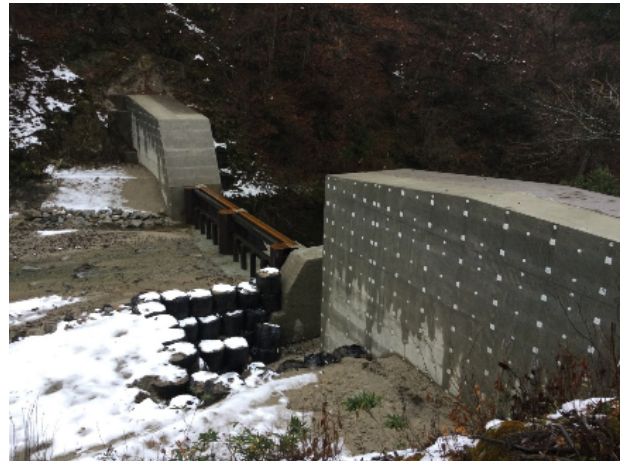
浅又川第1砂防堰堤 施工完了(2022年12月)
