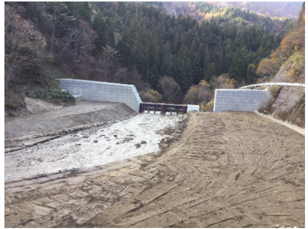
広瀬浅又川第2砂防堰堤 施工完了(2022年12月)
