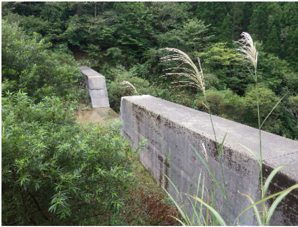
広瀬浅又川第2砂防堰堤 施工当初(2020年9月)
