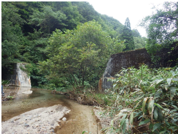
浅又川第1砂防堰堤 施工当初(2020年9月)
