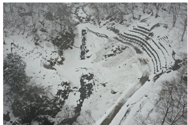
施工完了(2022年 1月)
