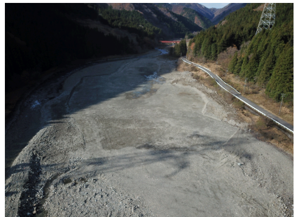
施工完了(2021年12月)
