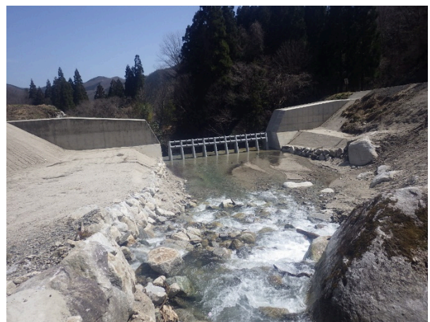
新穂谷第1砂防堰堤
