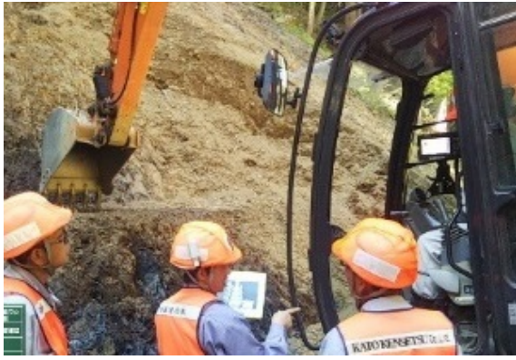
掘削時精度確認
