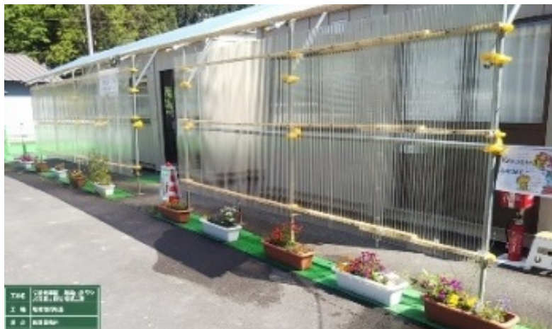
プランターの設置
