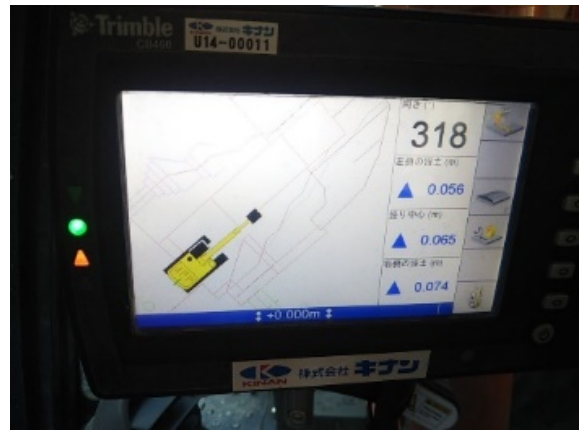
掘削機械(バックホウ)内のモニター
