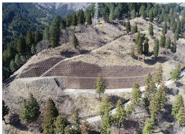
施工状況 2021年3月現在
