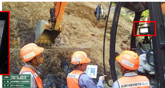
バックホウ内部のモニター
