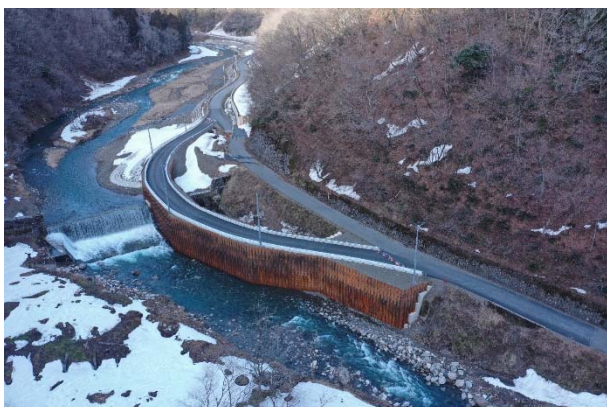
ナンノ谷砂防堰堤1号付近切廻し道路 施工状況 2021年3月現在
