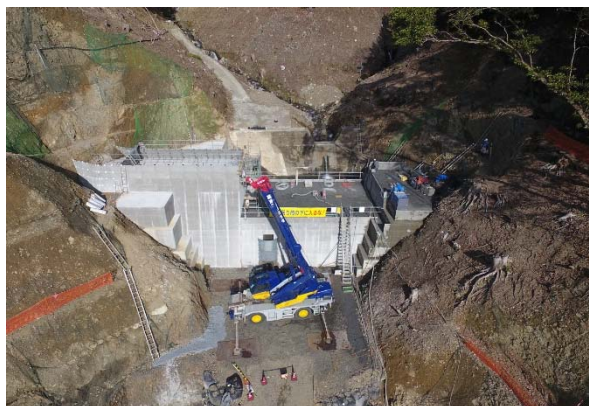
施工状況 2021年3月現在
