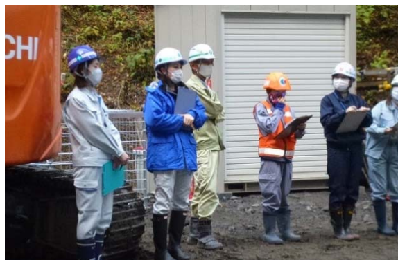
工事現場パトロールの結果報告（2020年11月）
