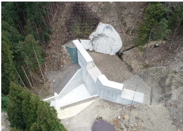
ガラン谷施工状況 2021年3月現在
