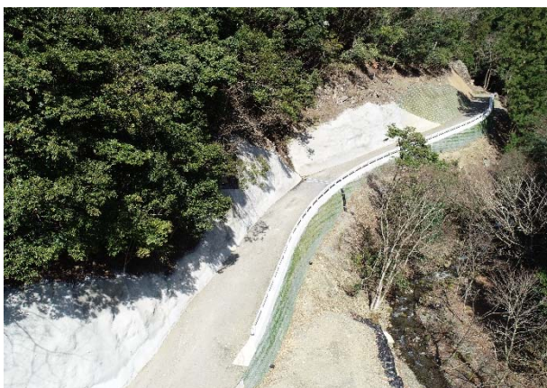
施工状況 2021年3月現在
