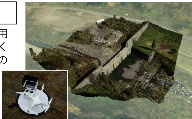
UAV撮影写真から砂防堰堤の3次元モデルを作成
