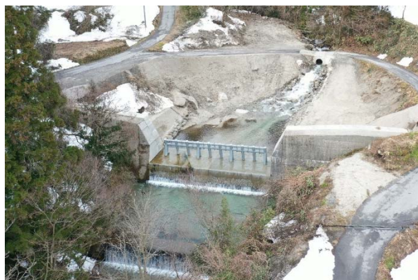
新穂谷第1砂防堰堤 2021年3月流木止め設置
