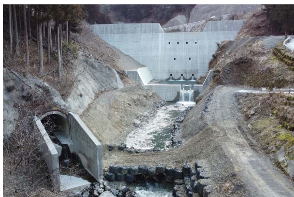
施工状況 2021年3月現在
