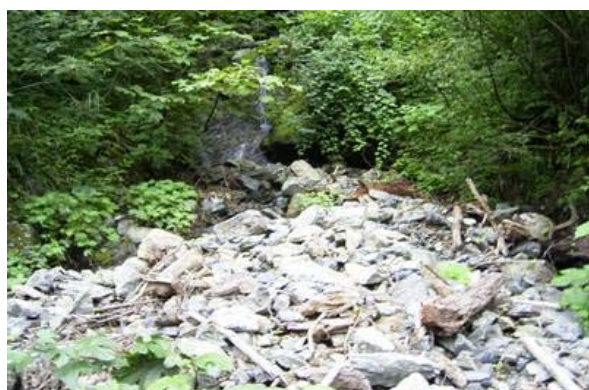
上流部の荒廃状況
