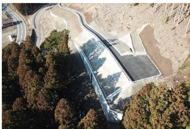
アテガ平谷施工状況 2021年2月現在
