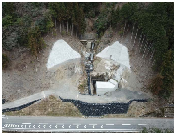
施工状況 2021年3月現在
