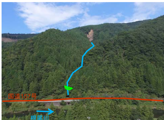
根尾川右岸より蛇抜谷を望む
