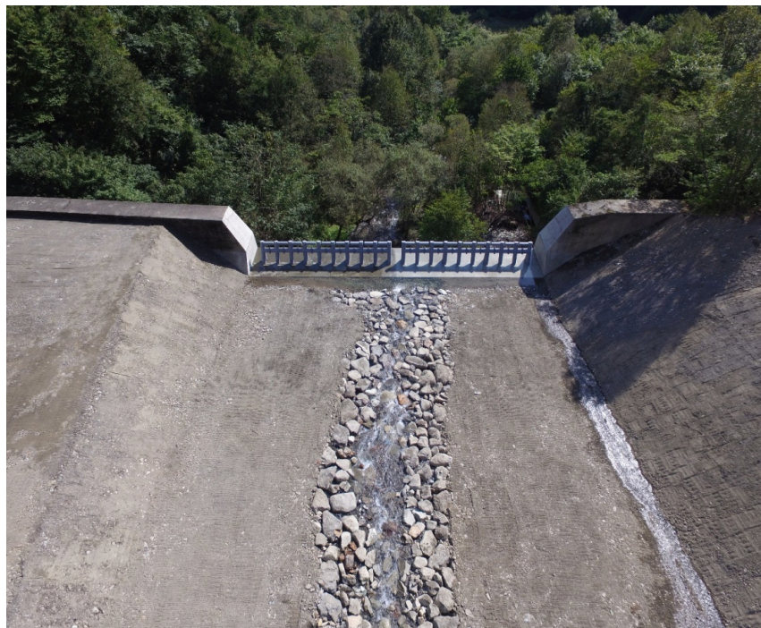
能郷谷第1砂防堰堤
