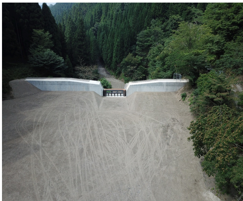
宮井谷第1砂防堰堤
