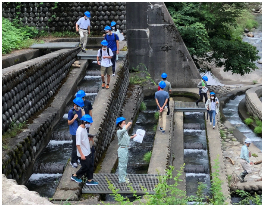
坂内砂防堰堤では、堰堤に設置された魚道を歩き、魚ののぼりやすさに配慮した構造を学習しました。
