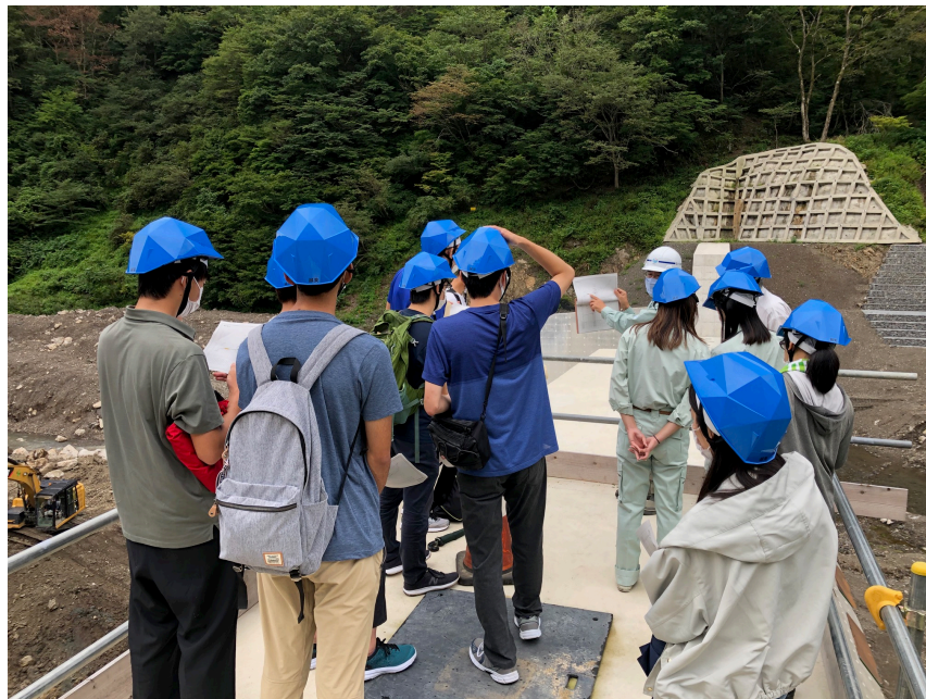
午後は、揖斐川筋の上流域へ足を運び、平成30年9月の降雨で破損したナンノ谷砂防ダム3号の災害復旧工事現場を見学しました。
