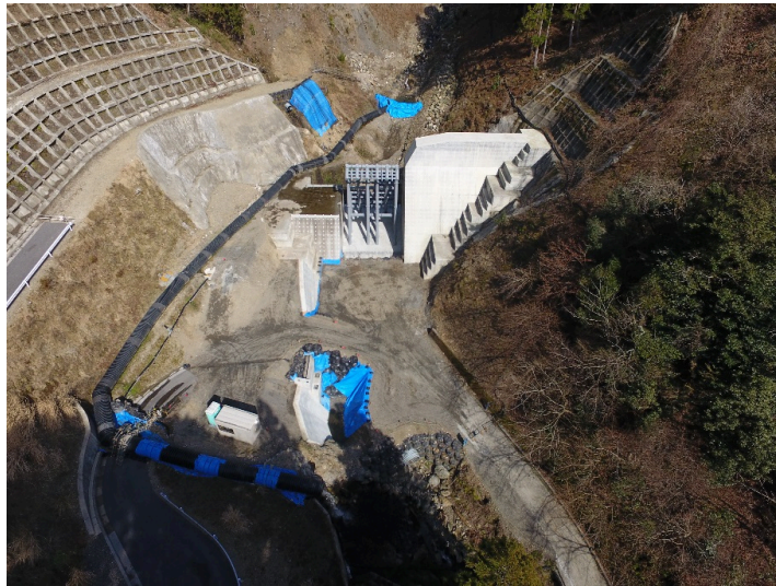
今回工事の完成
