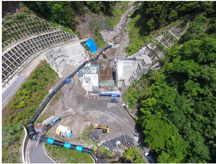
左岸袖軸のコンクリート打設時のヤード
