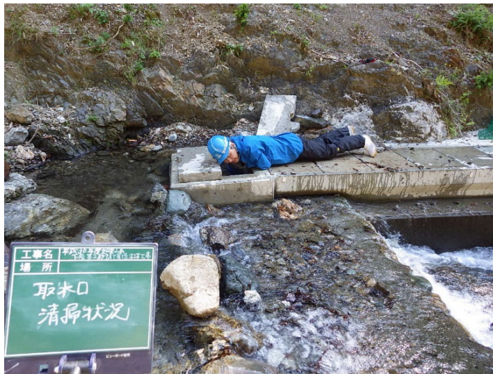
取水口の清掃状況
