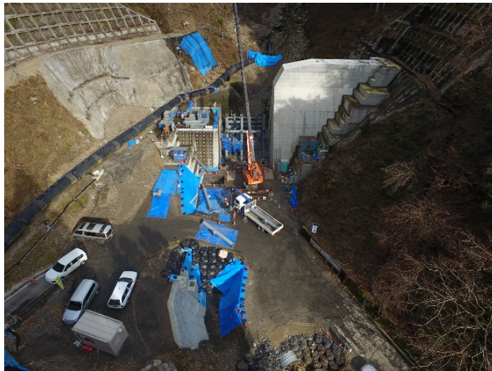
鋼管スリット据え付け時のヤード
