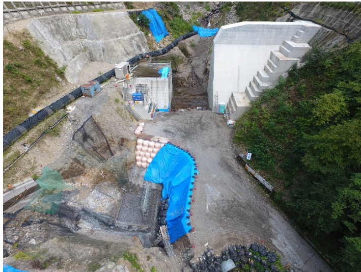
右岸橋台施工時のヤード
