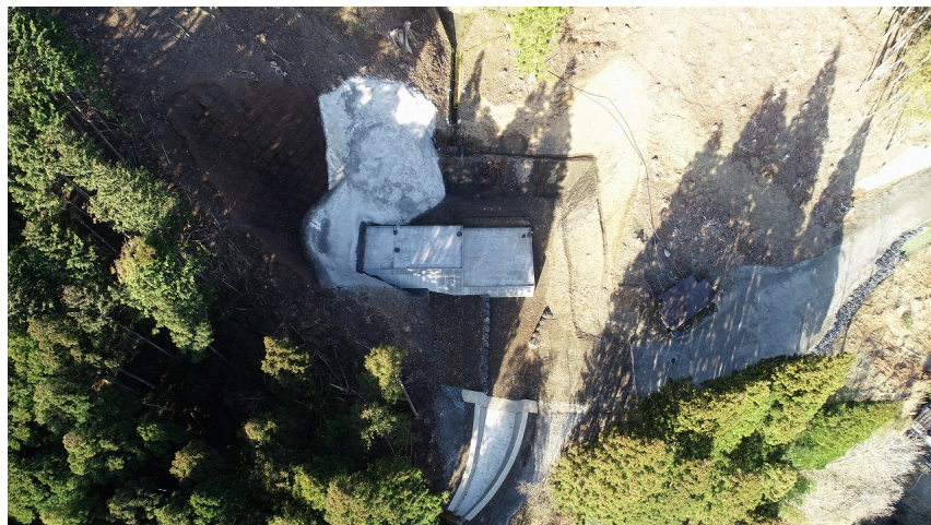
完成写真(下流上空より望む)
