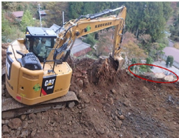
根株の撤去状況(赤丸内：仮設防護柵)
