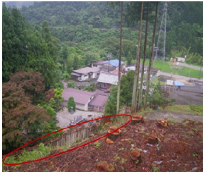
仮設防護柵の設置
