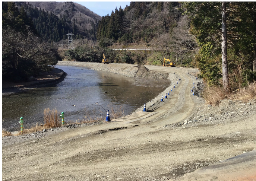
坂内堰堤 除石工
