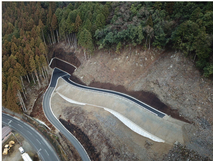
本工事の完成状況です。
