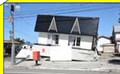
倒壊した家屋(1階が倒壊)
