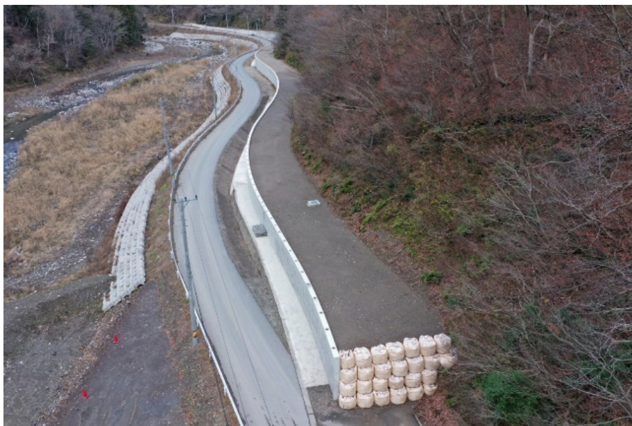
工事始点より望む
