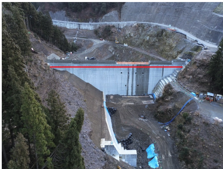
写真の赤線より下部：(本工事)平成30年度 越美山系高地谷第1砂防堰堤工事の施工 写真の赤線より上部：平成30年度 越美山系高地谷第1砂防堰堤副堤工事の施工
