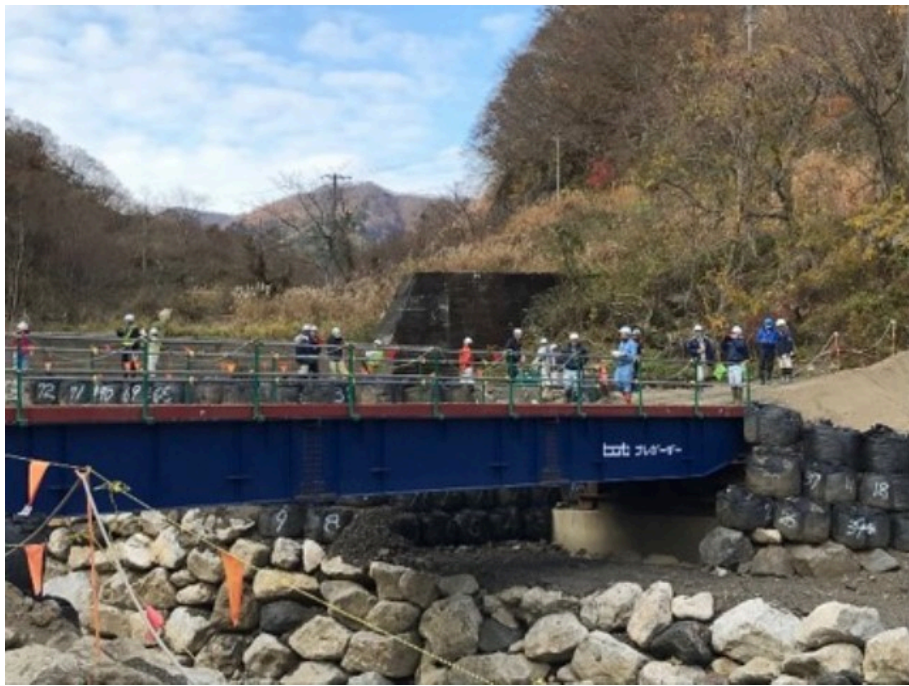
仮設橋を渡って堰堤施工現場へ
