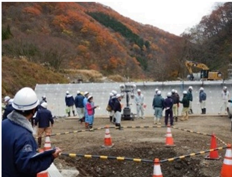
堰堤施工状況を見学
