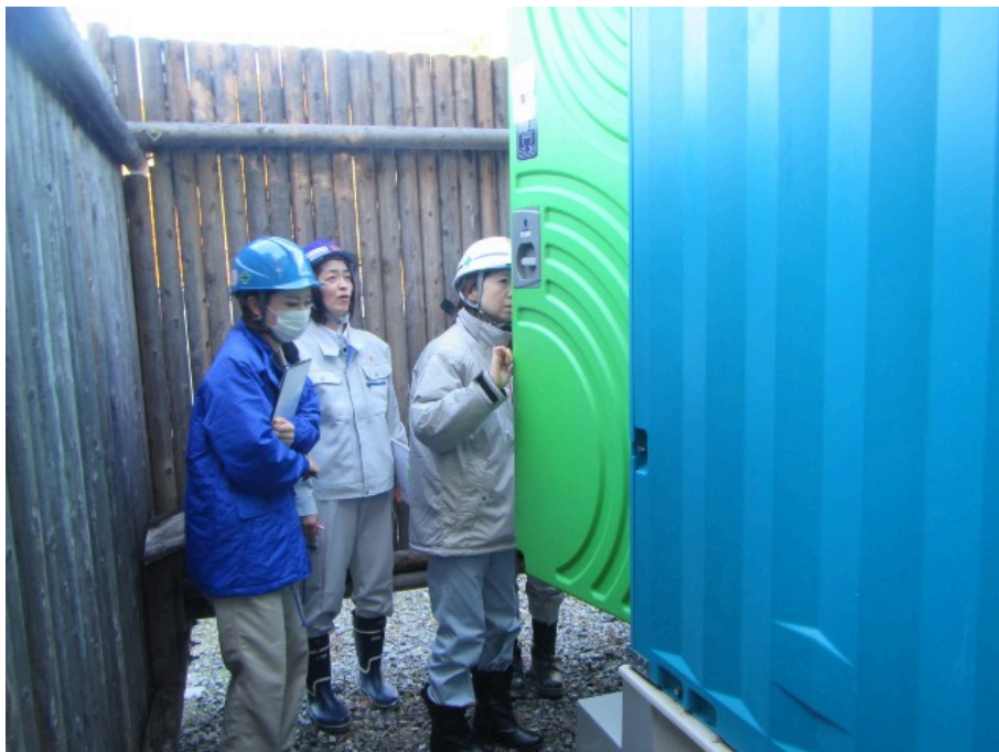
パトロール実施（トイレを点検）
