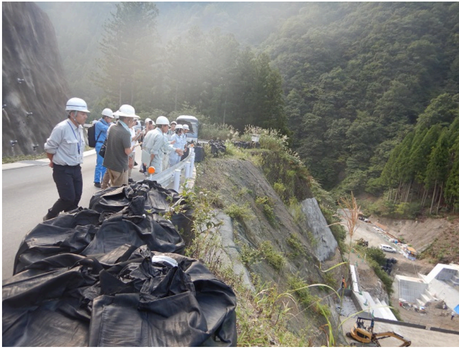
堰堤上の道路から望む高地谷第1堰堤
