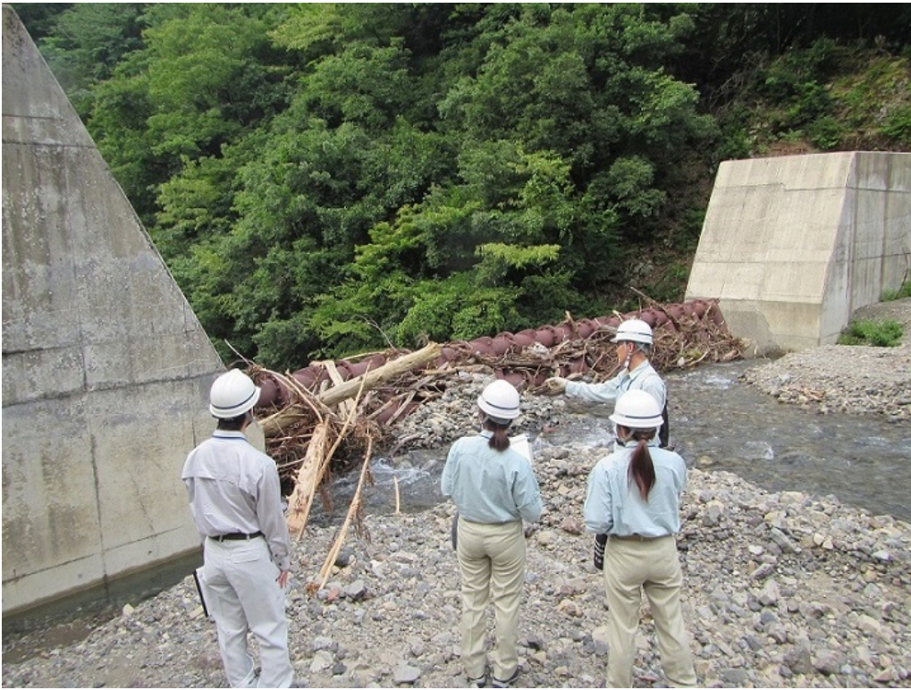
砂防施設点検（谷中谷第2砂防堰堤）
