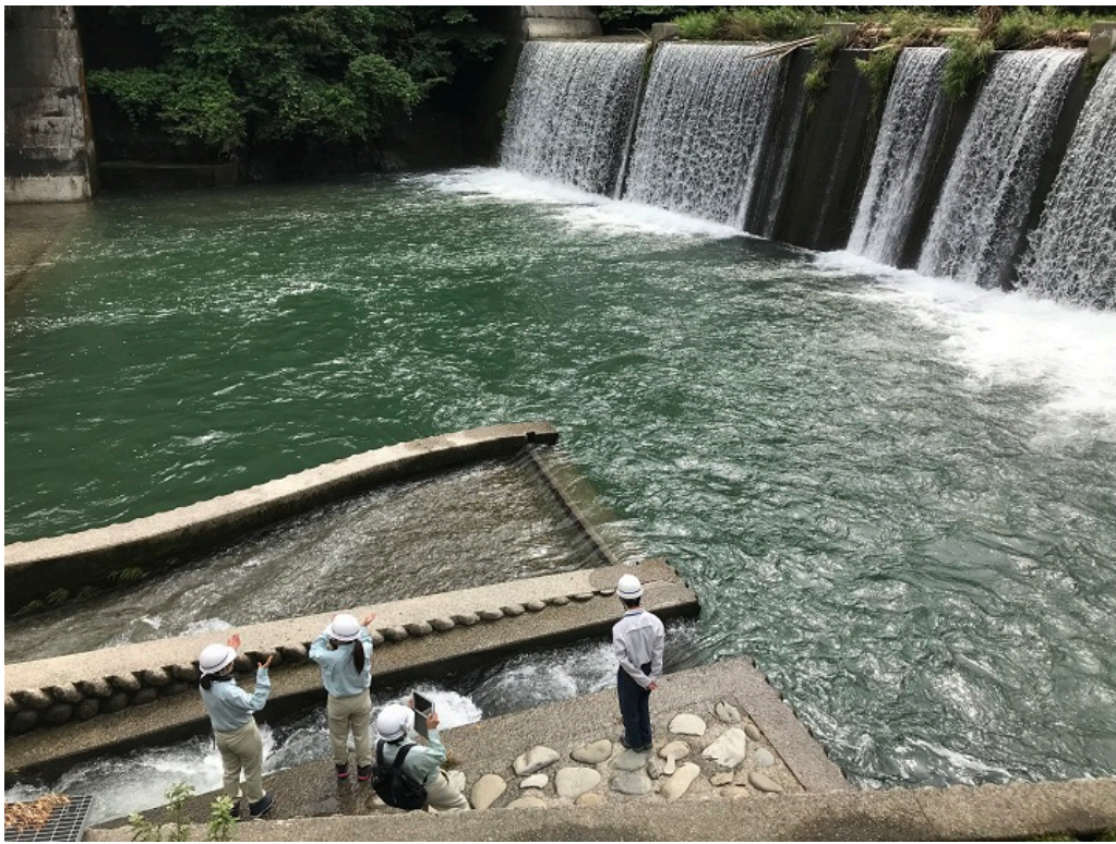
魚道見学（坂内砂防堰堤）
