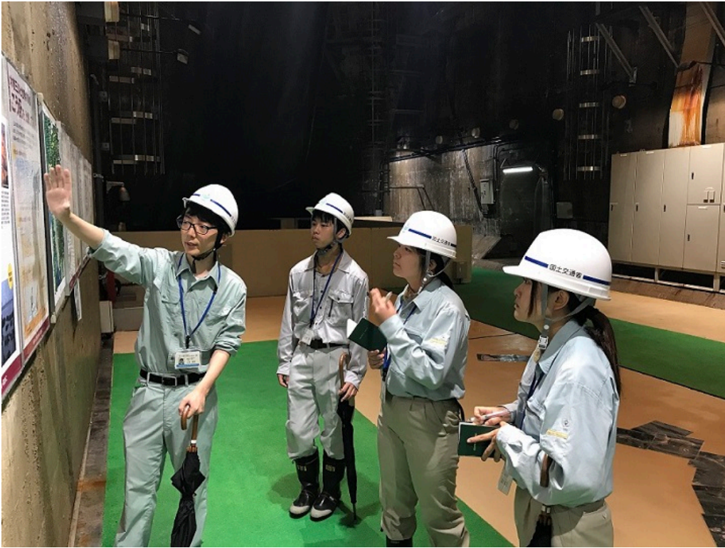
横山ダム堤体内
