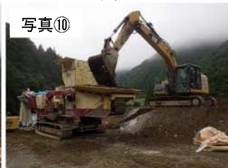
土砂投入状況
