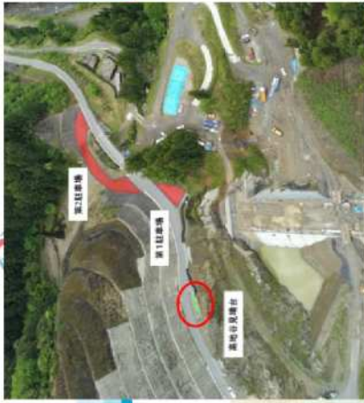
①高谷谷第1 砂防壩堤
