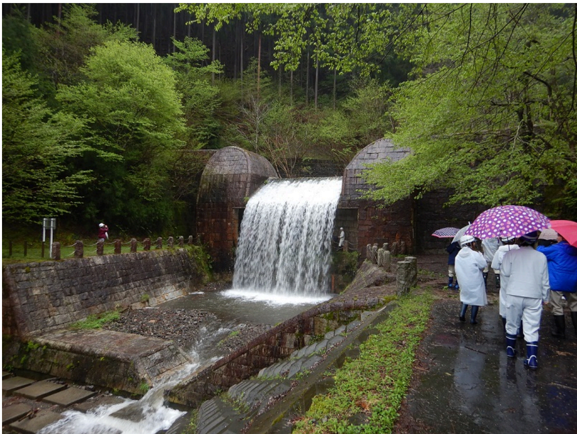
点検実施状況
