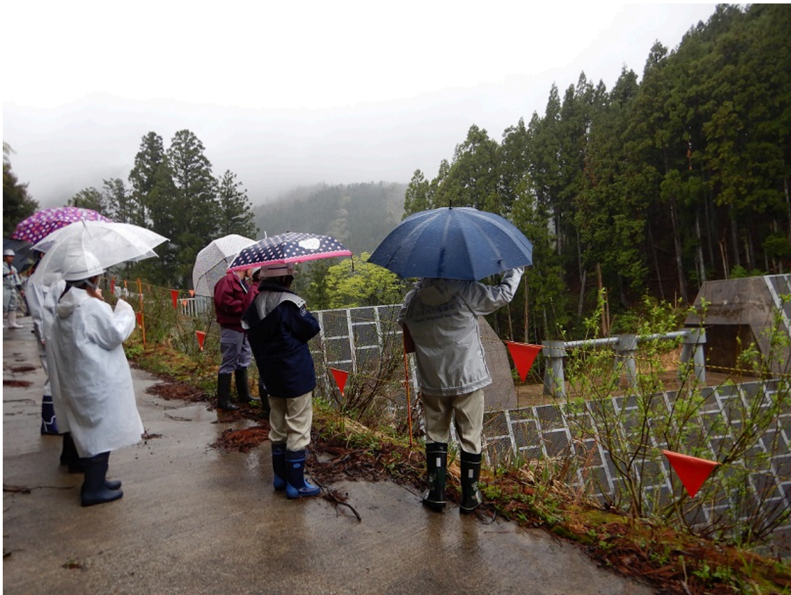
点検実施状況
