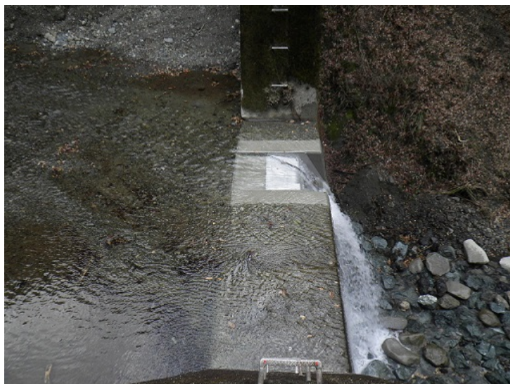
堰堤に設けられた取水施設
