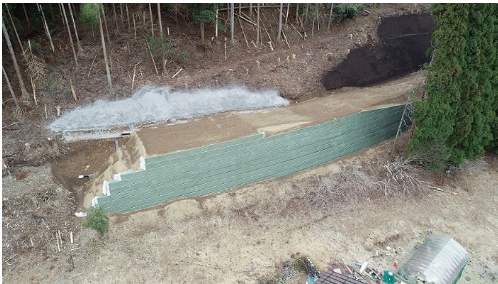
工事用道路として補強土壁を施工
