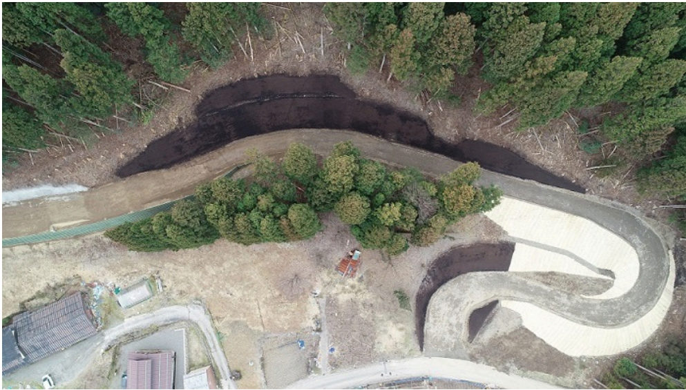
工事区間を上空から撮影
