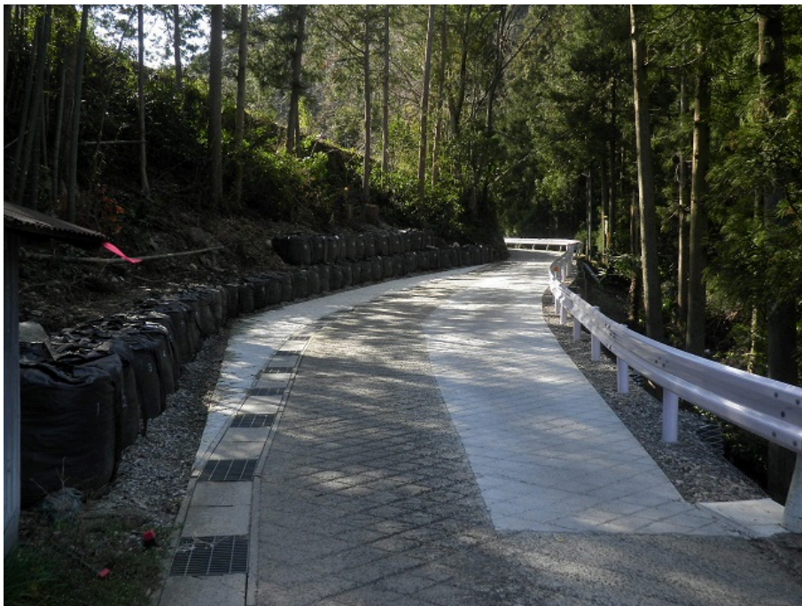
ブロック積で拡幅した道路
