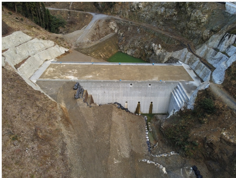
半分の高さまで完成（下流より望む）
