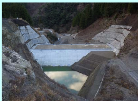
現在施工中の堰堤
