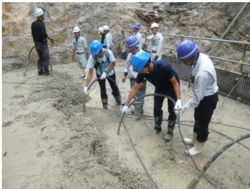
セメント締め固め体験（坂内白谷第1砂防堰堤）
