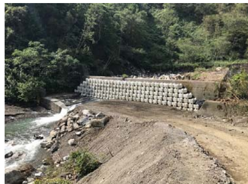
写真2 下流側対策後（9月17日）
