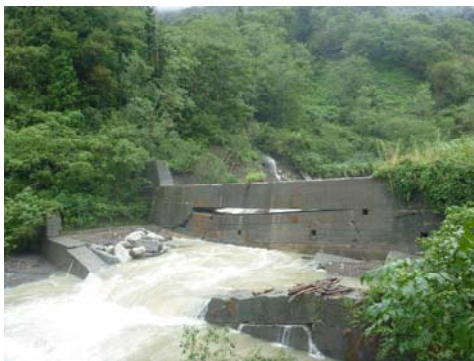
写真1 下流側対策前（9月10日）
