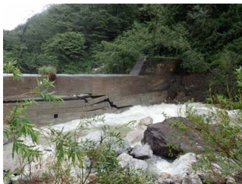
写真3 上流側対策前（9月10日）
