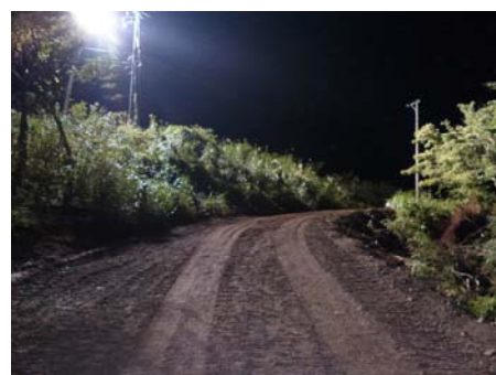
写真3 完成した工事用道路
