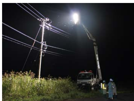
写真1 施工箇所を照らす照明車
