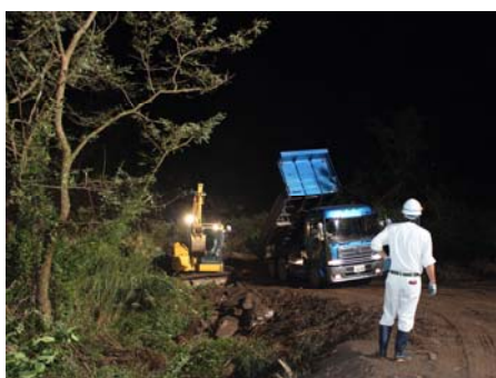
写真2 工事用道路施工状況
