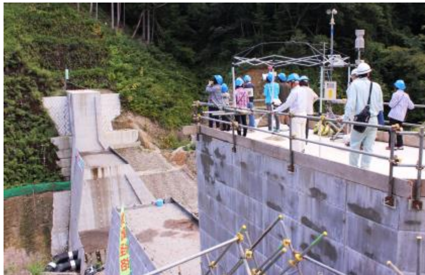
施工中の本堤上から工事現場を見渡します
