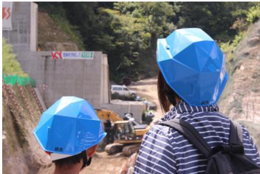
坂内白谷第1砂防堰堤にて
