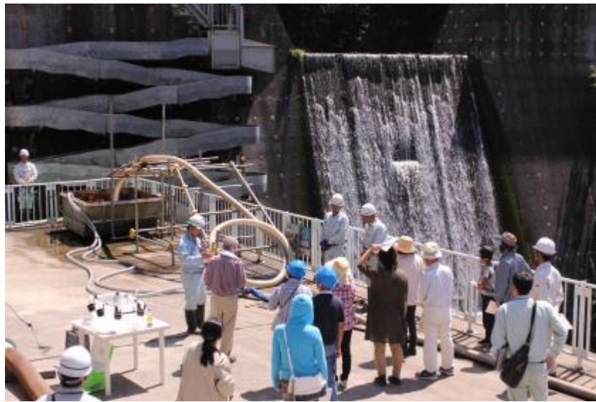
たて型壁面魚道を設置した山の谷第1砂防堰堤にて
