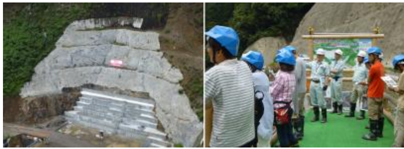
見晴台にて説明を受け、建設現場を見学中
