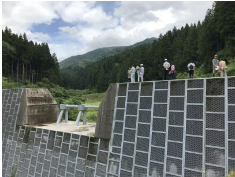
敷原谷第1砂防堰堤（本巣市根尾門脇）
