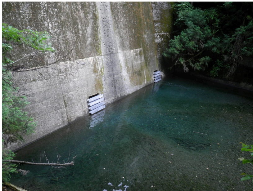
既設堰堤の暗渠閉塞工
