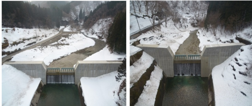
左：品又谷第1砂防堰堤、右：品又谷第2砂防堰堤
