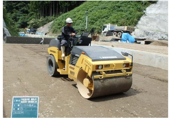
堰堤転圧管理の様子
