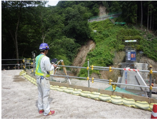
UAVによる法面点検の様子
