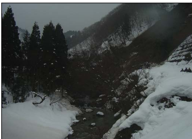
(1月13日崩壊後の状況)
