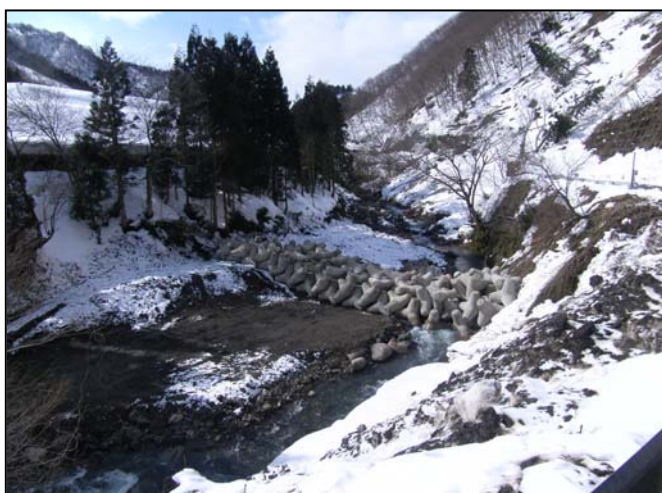
(2月25日応急対策工事完成後の状況)
