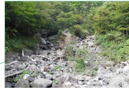
堆積状況 複数の支溪から流出した土石流の巨礫が堆積している。 幅 12\text{m} ×深さ 1.5\text{m} ×延長 120\text{m}=3,000\text{m}^3 程度
