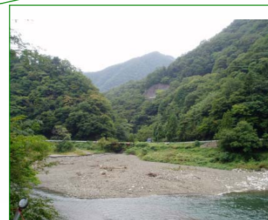
合流部状況 合流部の扇状堆積。1/2×幅 160m×延長 65m×厚 1.5m=7,800m 3 程度。
