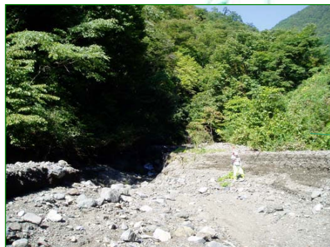
河床堆積状況 河床に一旦堆積した土砂が、後続流により浸食し流下している。 幅 27m×延長 90m×深さ 1.5m=3,600m 3 程度
