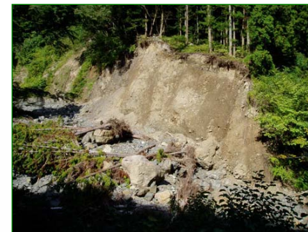
溪岸侵食・河床堆積状況 湾曲部では、溪岸侵食を拡大させ、崩壊した土砂の一部が流木とともに河道に堆積している。 幅 20m×延長 100m×深さ 1.5m=3,000m 3 程度
