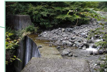
親谷第1砂防堰堤の効果 災害前も満砂状態にあったが、その上部で流出した土砂を捕捉し、土砂調節効果を発揮している。約 1,800\text{m}^3
