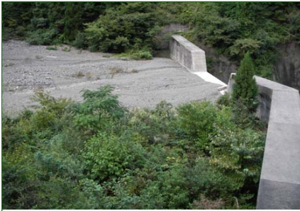
親谷第2砂防堰堤の効果 災害前も満砂状態にあったが、その上部で流出した土砂を捕捉し、土砂調節効果を発揮している。 約 3,400\text{m}^3
