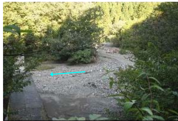
災害後 H20 満砂 約 10,000m 3 堆積
