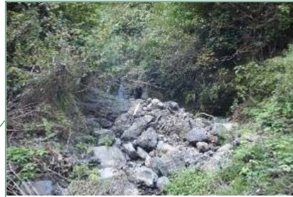
土砂流出状況
