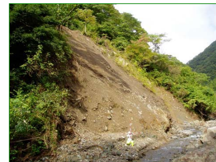
溪岸侵食状況 湾曲部では、溪岸侵食が激しく、至る所で崩壊を発生させ、土砂流出を拡大している。 幅 30m×高 15m×深さ 1m=450m 3 程度
