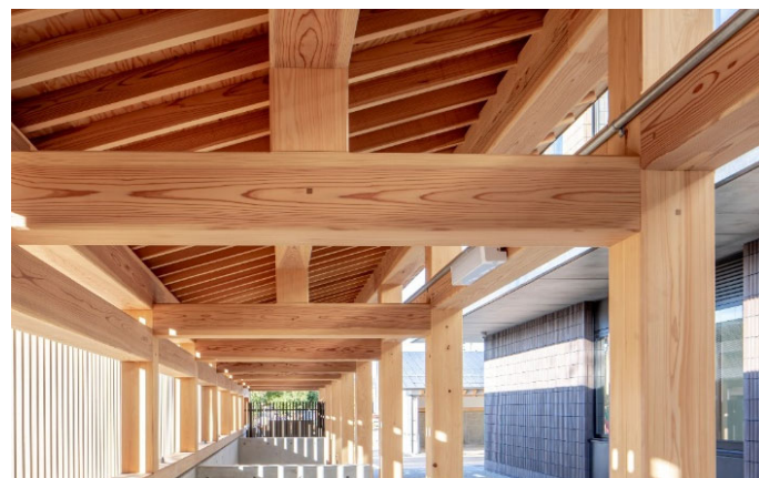
自転車置場C (軸構造系 伝統工法)
