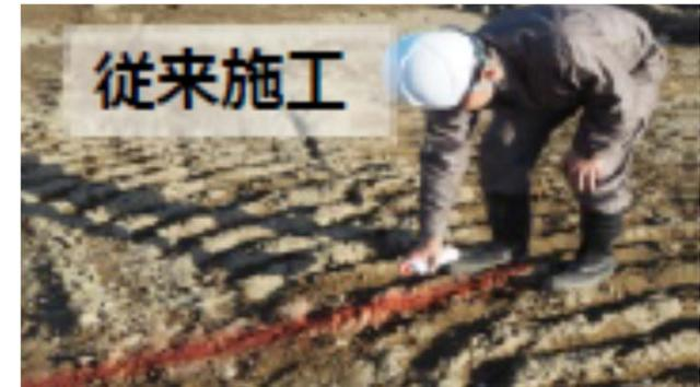
従来は作業員が位置出しを実施、掘削時の手元作業も削減され安全性も向上
