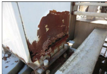
屋外制御盤の錆
