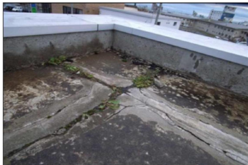
防水押さえコンクリートの損傷
