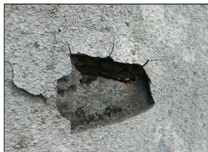
鉄筋の腐食
