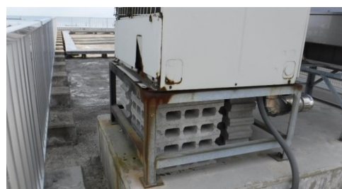
腐食した屋外機下に設置したコンクリートブロック
