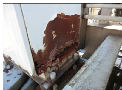
屋外制御盤の錆
