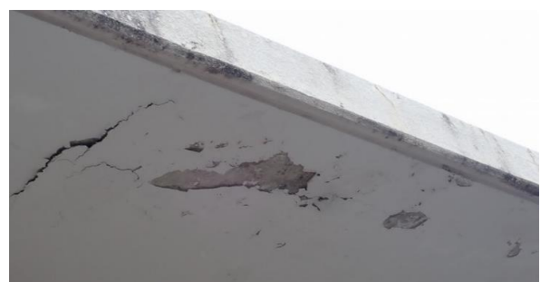
軒裏コンクリートの剥落
