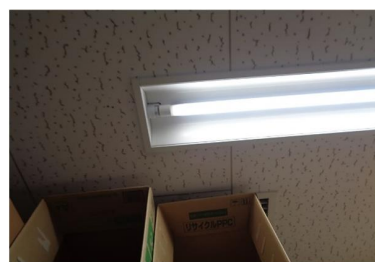
ランプのみ直管型LEDに交換されている照明器具
