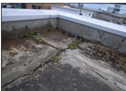
防水押さえコンクリートの損傷
