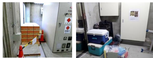
電気室等の物品放置の事例
