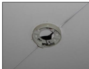
撤去されたまま放置されている火災報知器
