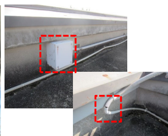
電気配管からの漏水危険箇所
