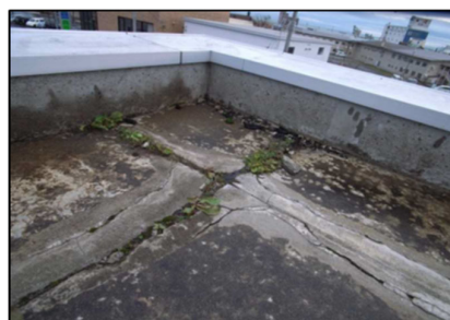
防水押さえコンクリートの損傷
