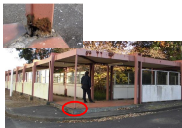
渡り廊下支柱の腐食
