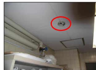
撤去されたまま放置されている火災報知器
