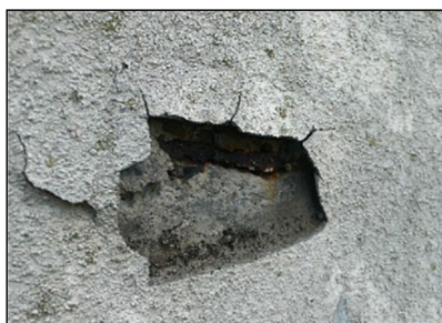
鉄筋の腐食
