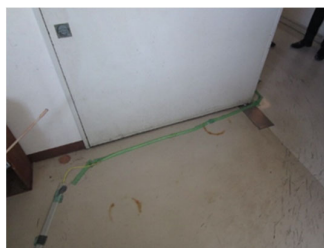
防火扉の開閉範囲に通信ケーブルを設置
