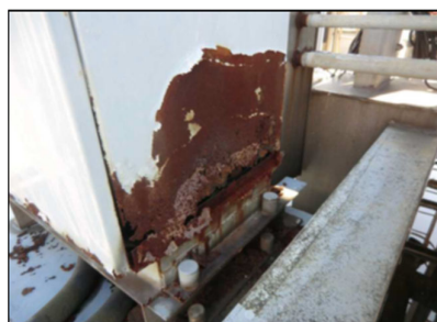
屋外制御盤の錆
