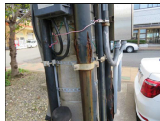
電気配管の腐食
